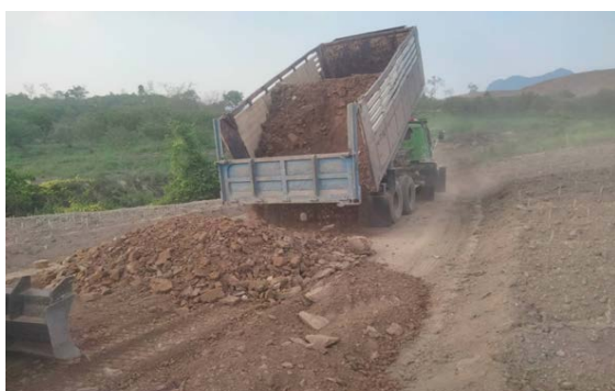
รูปขณะดำเนินงาน
