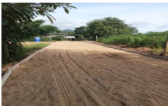
รูปขณะดำเนินงาน
