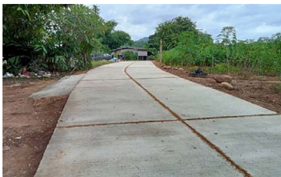
รูปดำเนินงานแล้วเสร็จ
