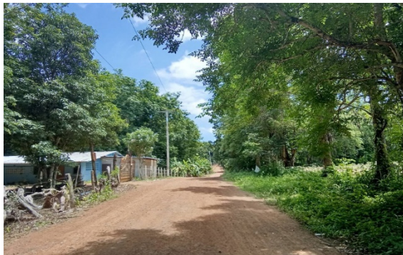
รูปขณะดำเนินงาน
