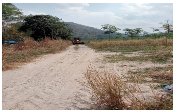
รูปขณะดำเนินงาน
